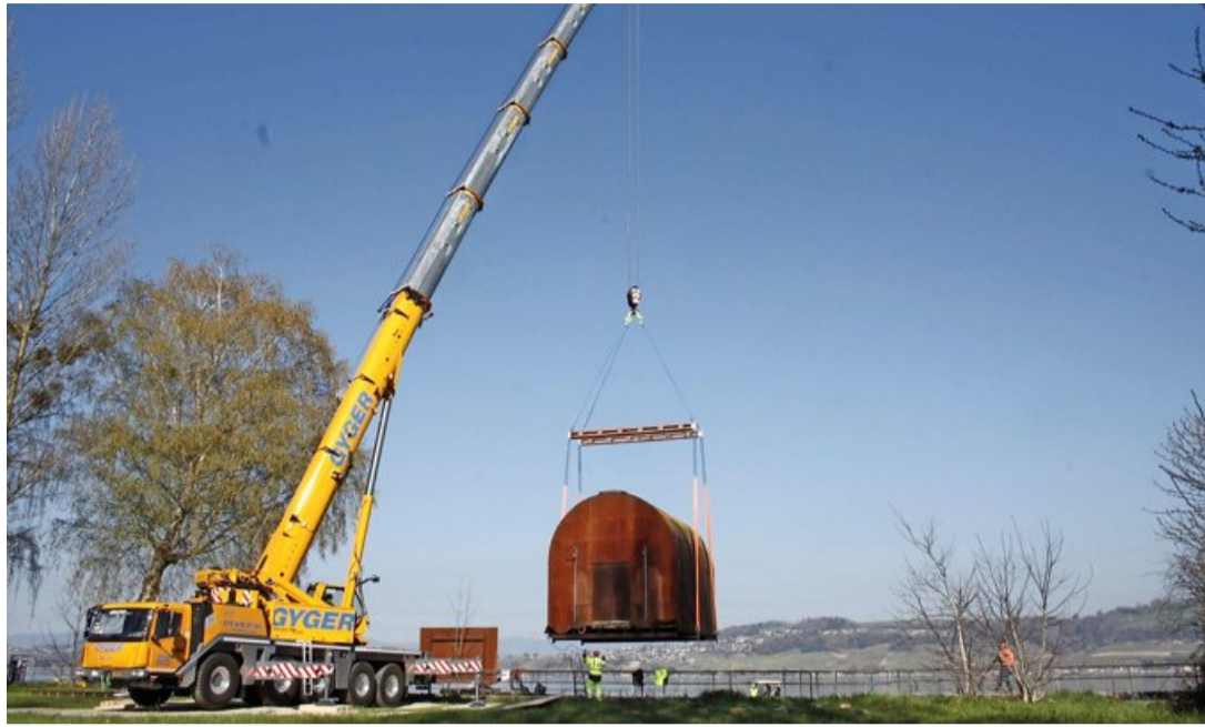
Luftreise: Die Cabane von Muntelier wird temporär versetzt, damit die Pfähle ersetzt werden können. Foto: E. Müller
